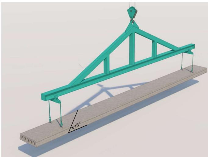
Lors d'une manutention avec des ancrs de levage, il est indispensable d'avoir un angle de minimum 45° entre le hourdis et les chaînes.
